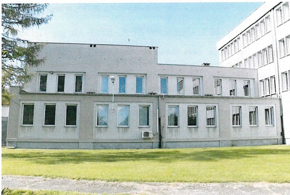
Ryc. 2. Budynek – niższa część od strony zachodniej
