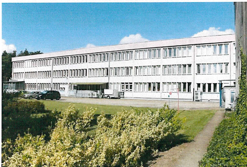
Ryc. 3. Budynek – część główna północna
