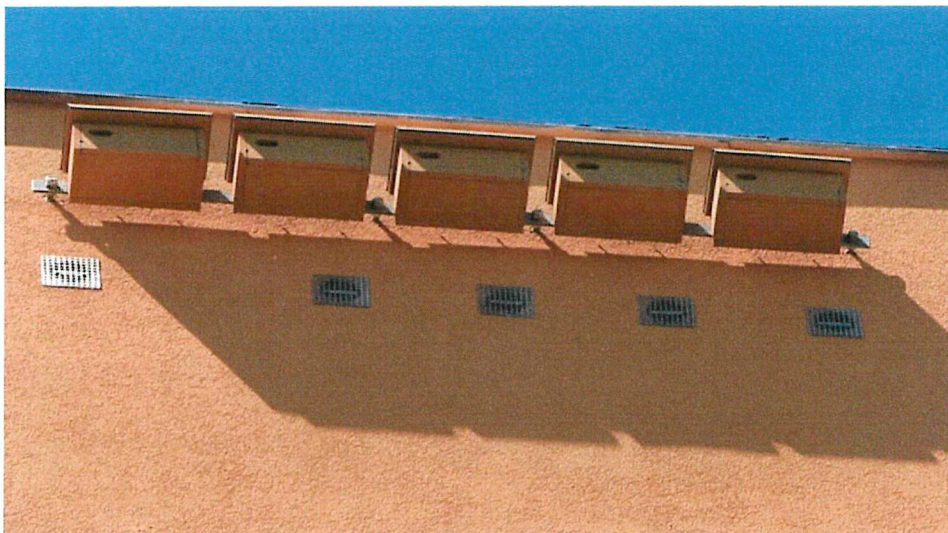
Ryc. 6. Przykładowy sposób zamocowania pięciu budek dla jerzyka typu APK-1 do budynku – za pomocą płaskownika i czterech kotew mocujących płaskownik do ściany budynku, przechodzących przez warstwę termoizolacyjną.
