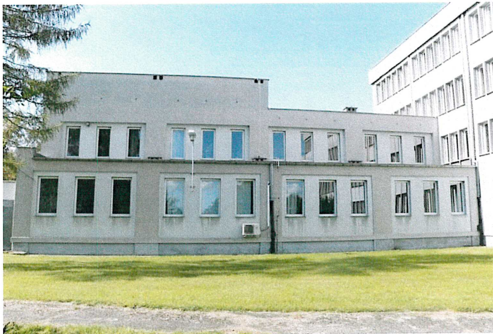
Ryc. 2. Budynek – niższa część od strony zachodniej
